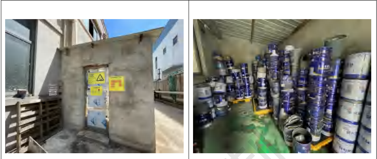
图 4.1-4 危废仓库现场图
