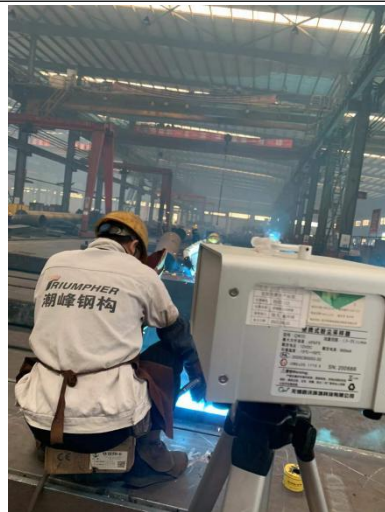
生产车间/二保焊岗
