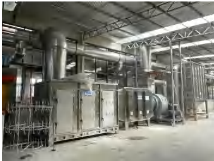
图 3-2 熔化废气、天然气燃烧废气、脱模有机废气处理设施图
