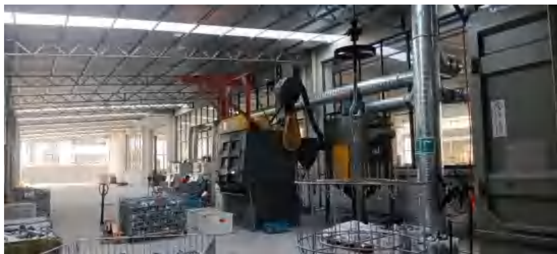
图 3-4 抛丸废气、打磨抛光废气处理设施图
